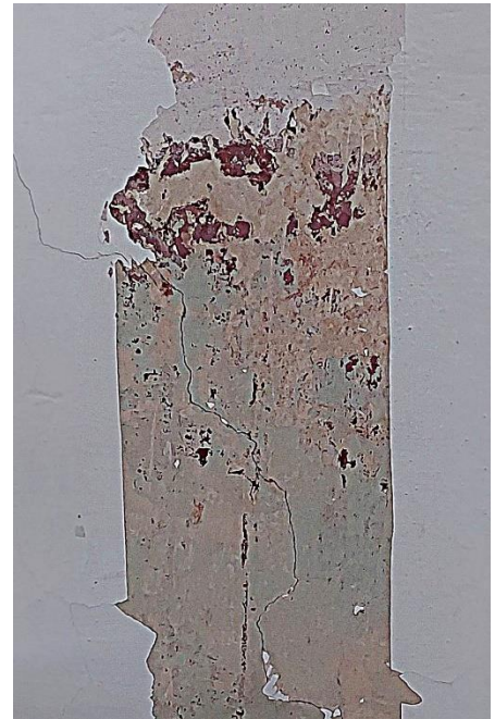
Fot. 11 Odkrywka na lamperii. Początkowo, tak jak kroksztyny, pomalowana była na kolor ciemnoczerwony. Później pomalowano ją na jasnożółty, jasnosedynowy i na końcu na biały.
