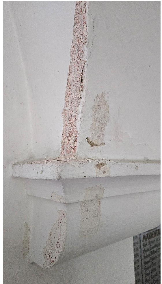
Fot.5,6 Odkrywki na konsolach wewnątrz świątyni. Detale zostały otynkowane, a następnie pomalowane kilkakrotnie. Kolejne warstwy farb:
