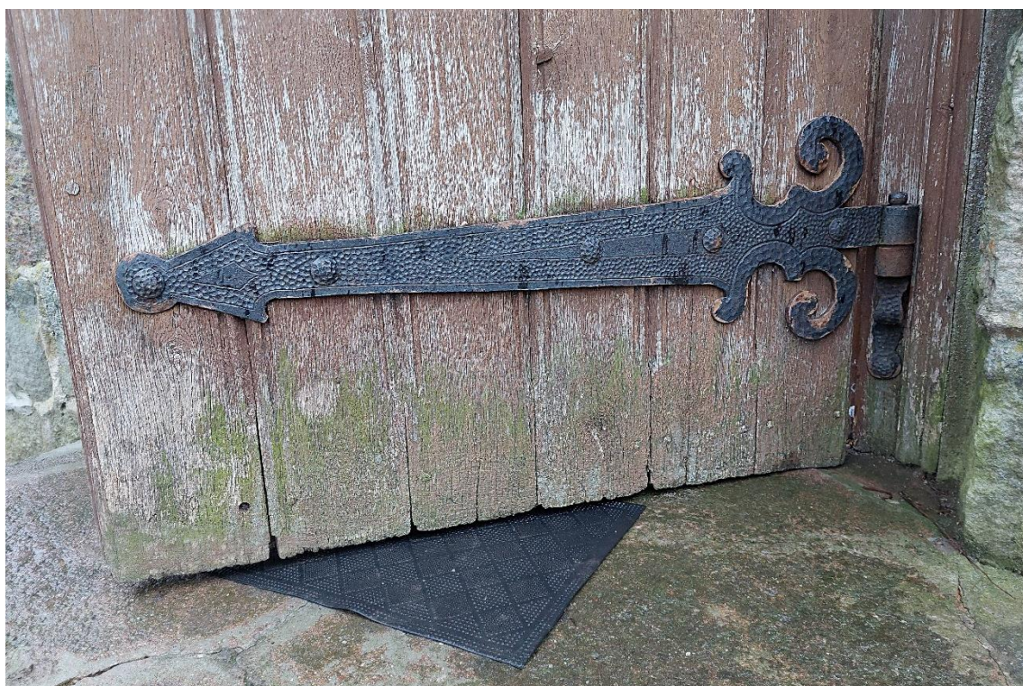
Fot. 30 Dolne odcinki desek są zniszczone przez brak zabiegów profilaktycznych.
