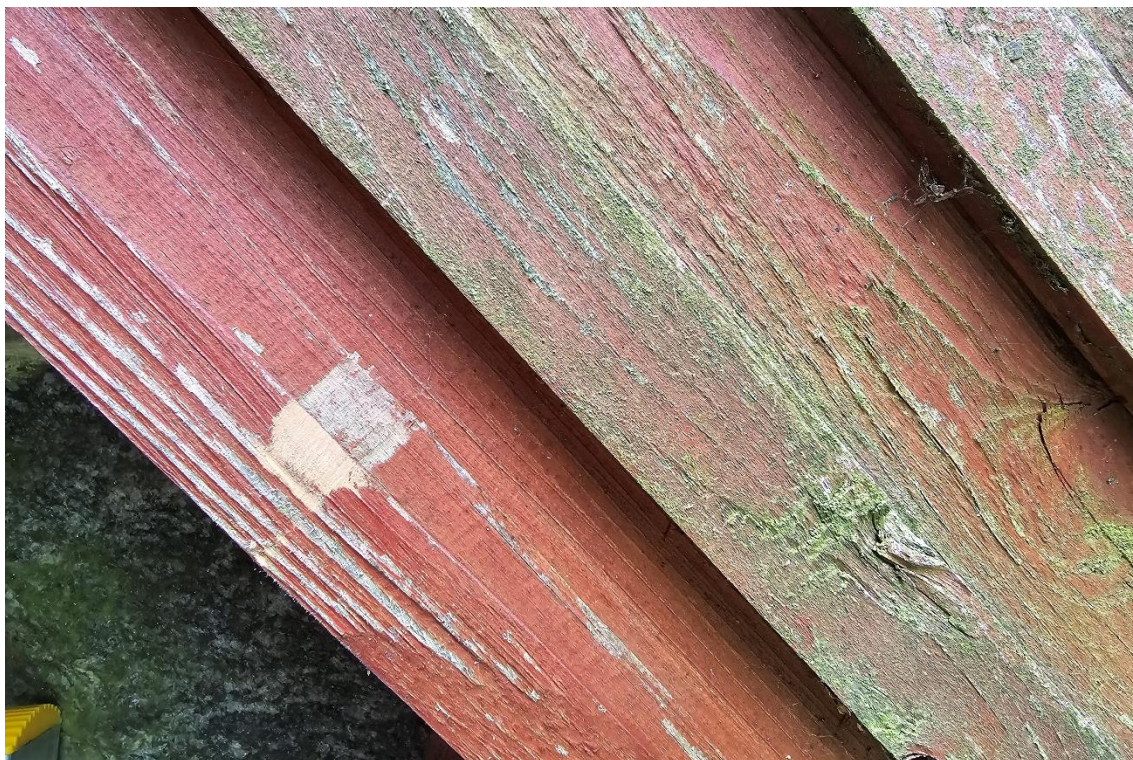
Fot. 4 Fragment deskowania okapu poddachowego. Część desek wymalowana jest farbą kryjącą (olejną) w kolorze czerwonym, która złuszcza się i odsłania korodujące drewno. Najprawdopodobniej jest to pozostałość oryginalnego wykończenia.
