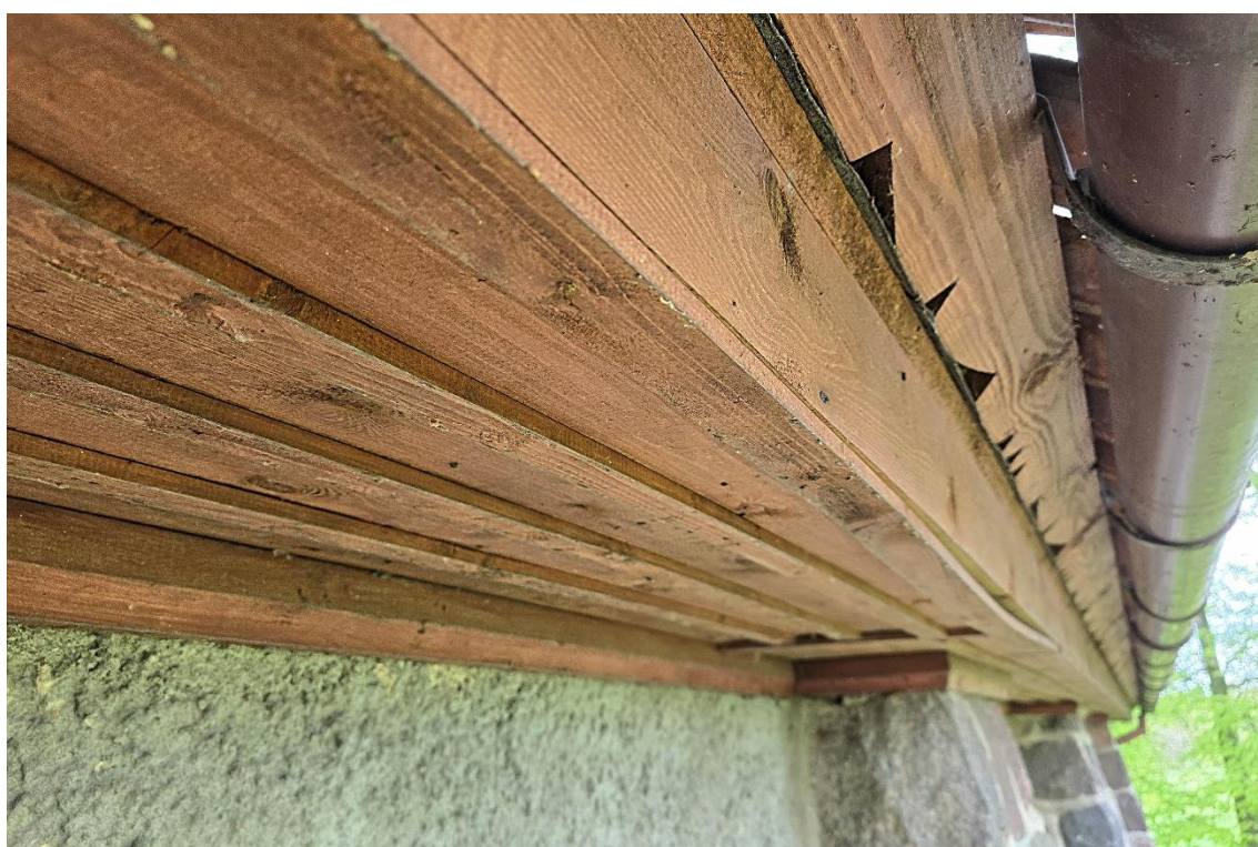
Fot. 4 Fragment deskowania okapu poddachowego. Część desek wymalowana jest farbą kryjącą (olejną) w kolorze czerwonym, która złuszcza się i odsłania korodujące drewno. Najprawdopodobniej jest to pozostałość oryginalnego wykończenia.
