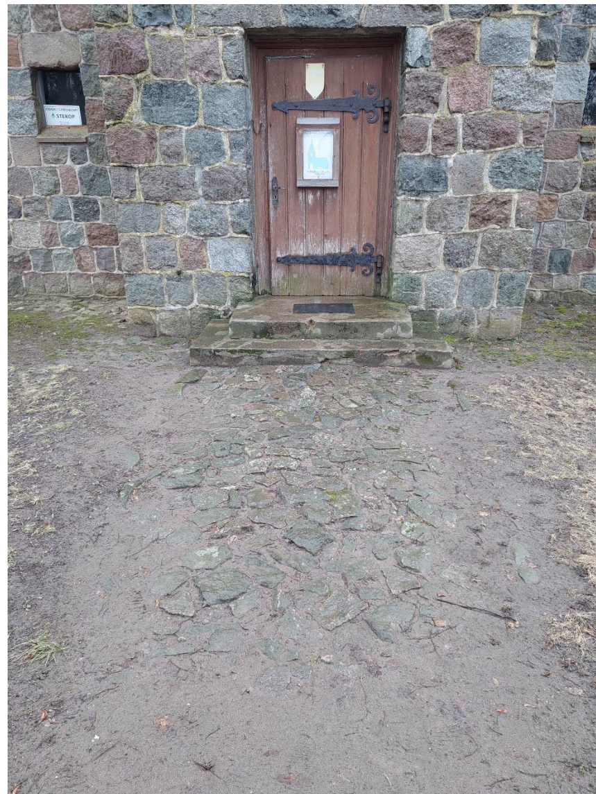
Fot. 26 Dojście do wejścia należy powtórnie wybrukować kamieniem wykorzystanym z opasek.
