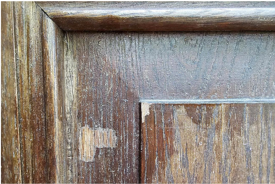
Fot. 1 Fragment drzwi głównych od strony wewnętrznej. Drewno zachowało się w bardzo dobrym stanie. Odkrywka wykazała, że pokryto je warstwą bejcy i lakieru.
