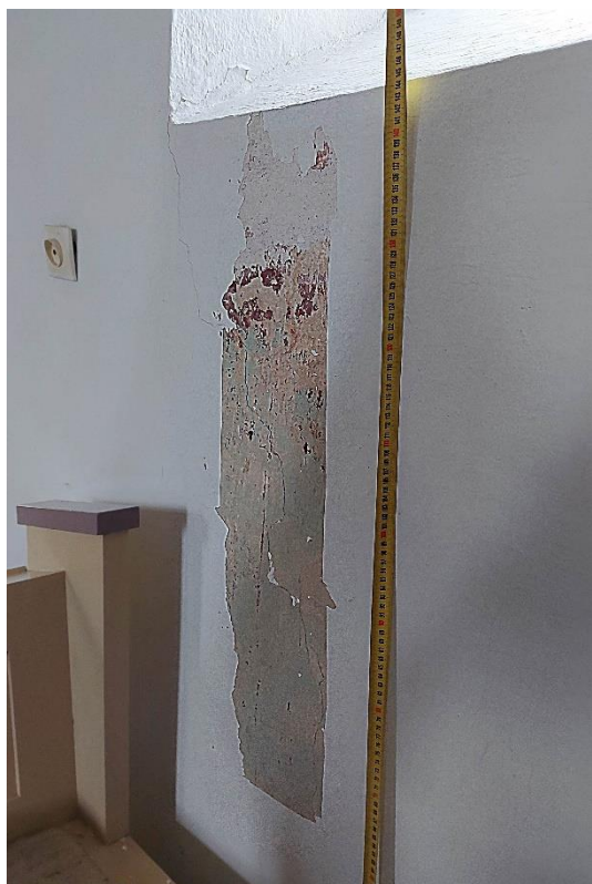
Fot. 8 Odkrywka wykonana na lamperii.
