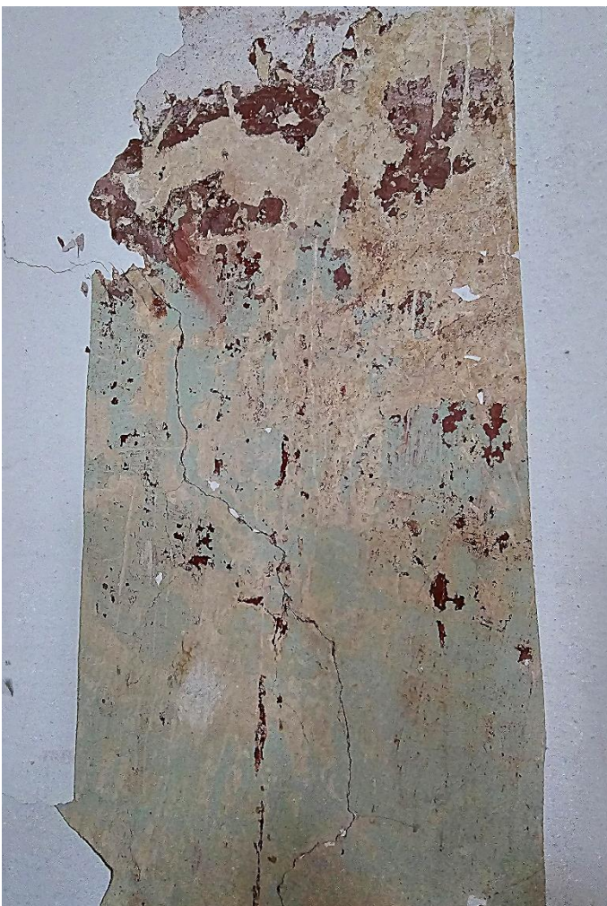
Fot.5,6 Odkrywki na konsolach wewnątrz świątyni. Detale zostały otynkowane, a następnie pomalowane kilkakrotnie. Kolejne warstwy farb:
