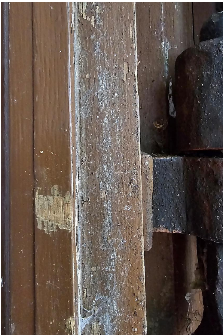
Fot. 2 Fragment futryny drzwi głównych. Wykonano odkrywkę. Ujawniono, że drewno zostało pomalowane wtórnie farbą olejną w kolorze ugrowym. Oryginalnie było lakierowane jak na drzwiach.
