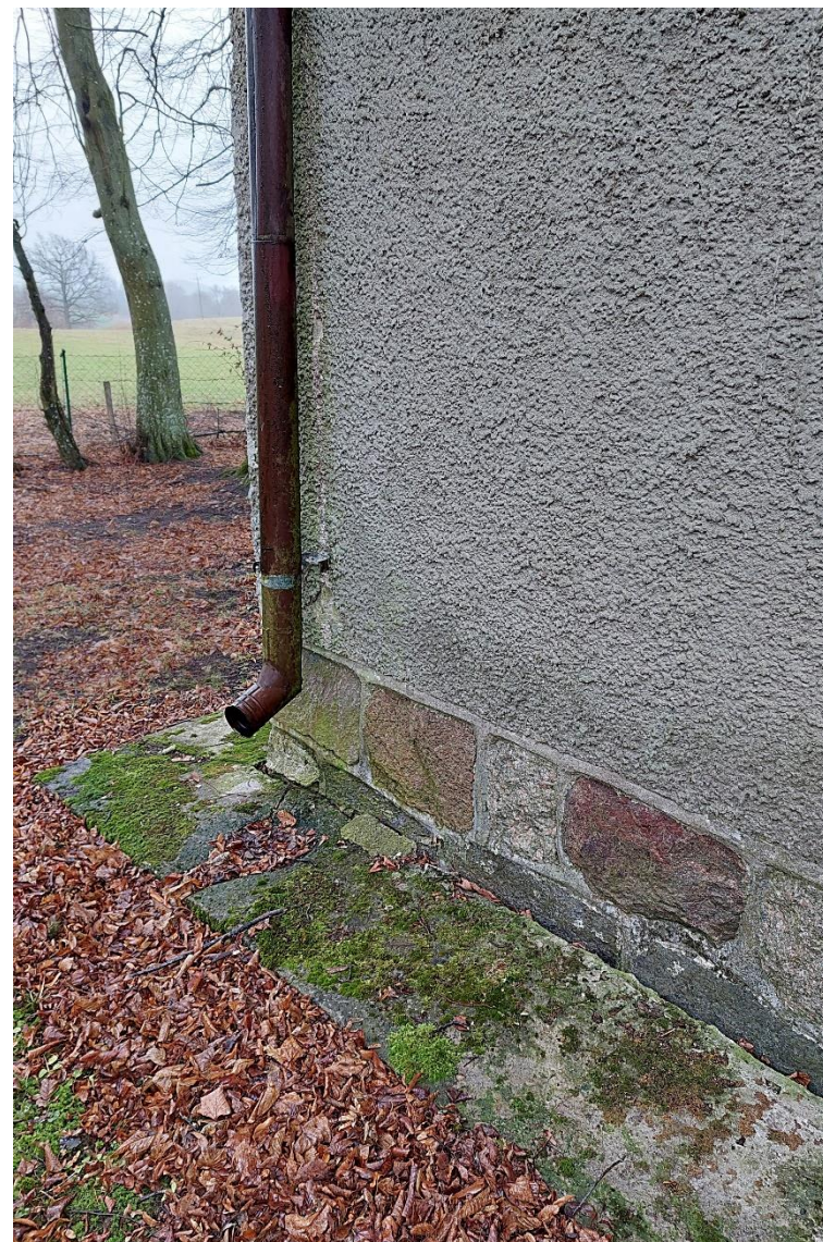
Fot. 19, 20 Mury oraz kamienno – betonową opaskę wokół kościoła miejscowo porastają glony i mchy.
