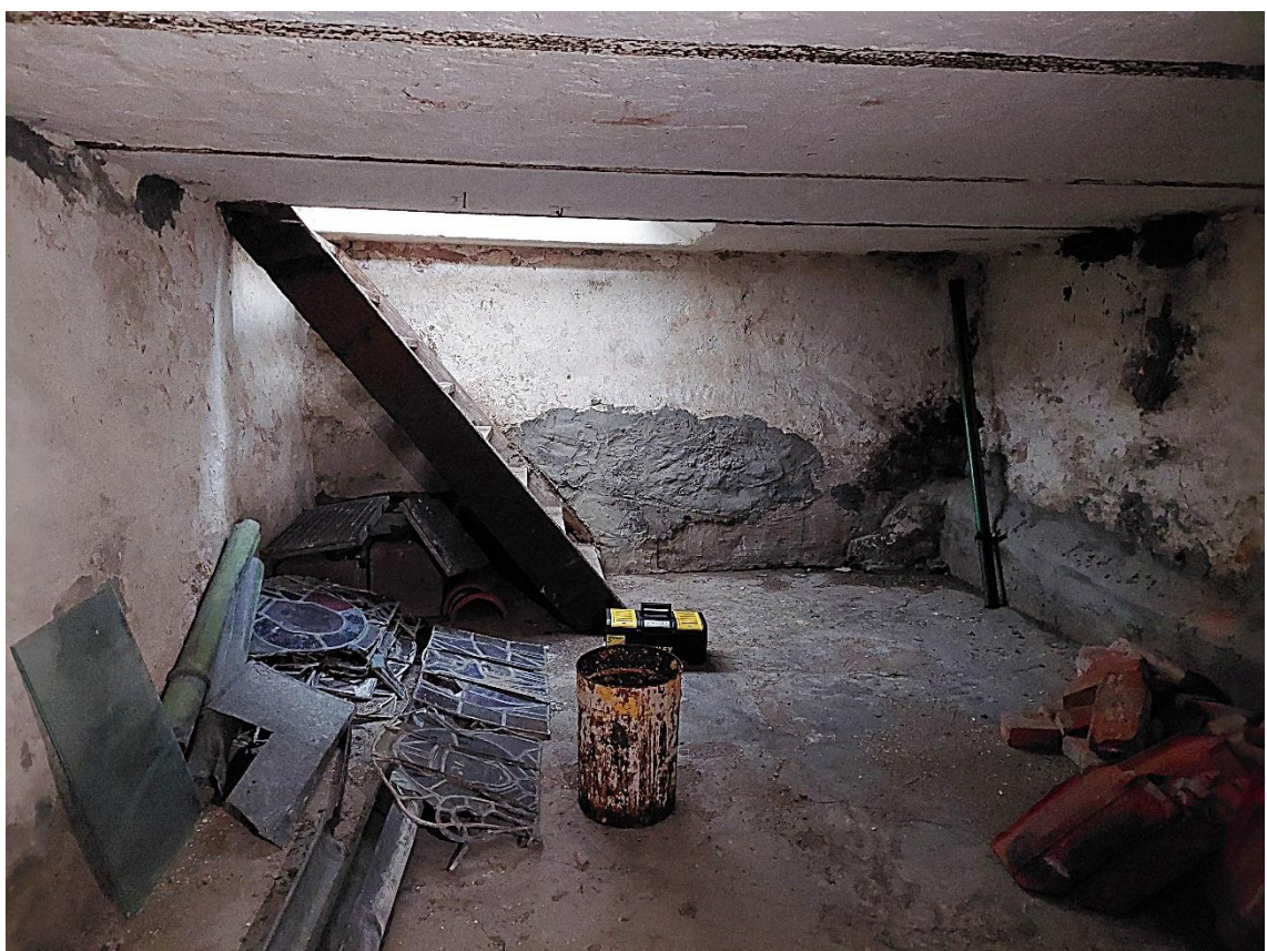
Fot. 43, 44 Wnętrze krypty pod prezbiterium. Dzięki jednemu okienku, wewnątrz następuje wymiana powietrza i nie rozwija się grzyb.
