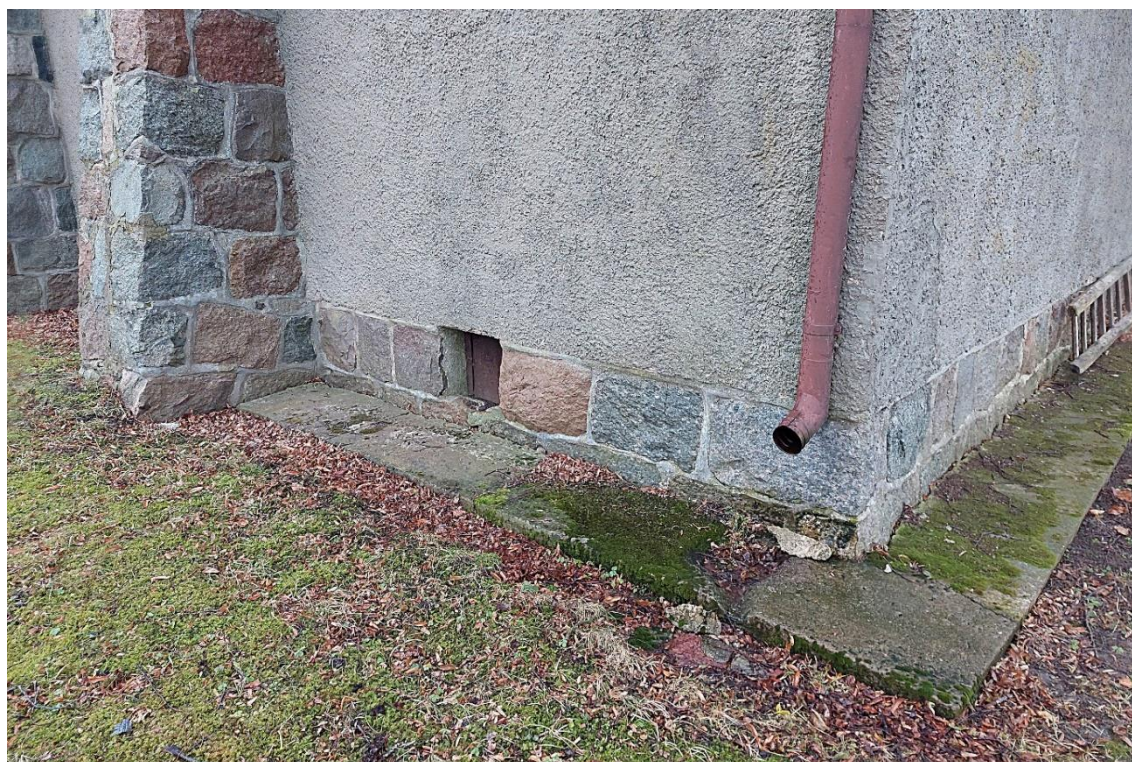
Fot. 22 Przez brak korytek odprowadzających wodę opadową i odpowiedniego wyprofilowania terenu, wilgoć długotrwale utrzymuje się przy murach obwodowych co sprzyja rozwojowi mchów i glonów.
