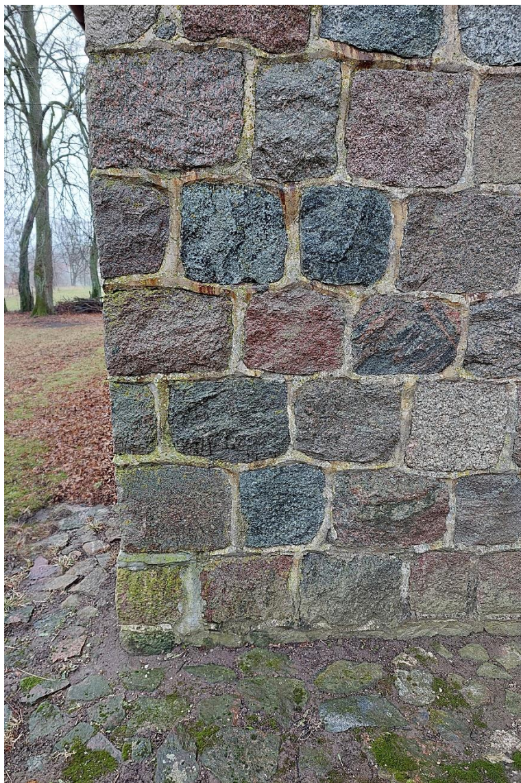
Fot. 19, 20 Mury oraz kamienno – betonową opaskę wokół kościoła miejscowo porastają glony i mchy.
