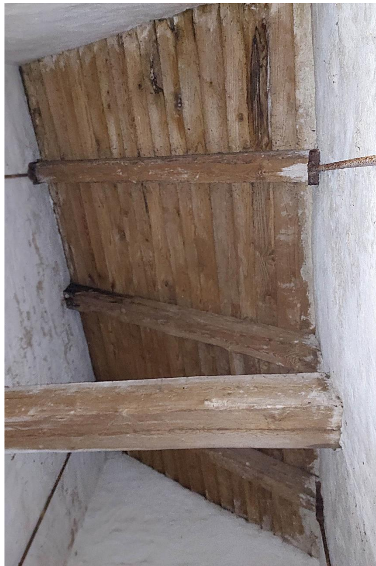
Fot. 38 Pulpitowy dach wieży widziany od spodu.
