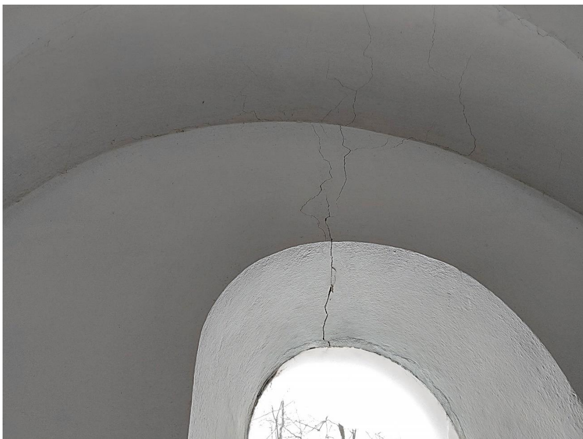
Fot. 35, 36 Nad otworami okiennymi pojawiły się głębokie pęknięcia murów.
