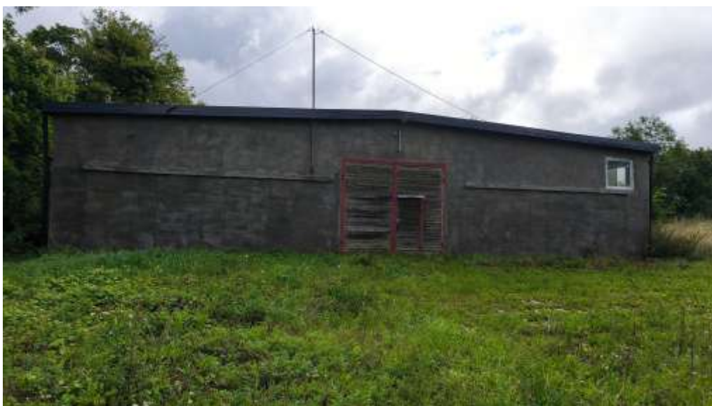
fot.1 istniejąca zabudowa magazynowa
